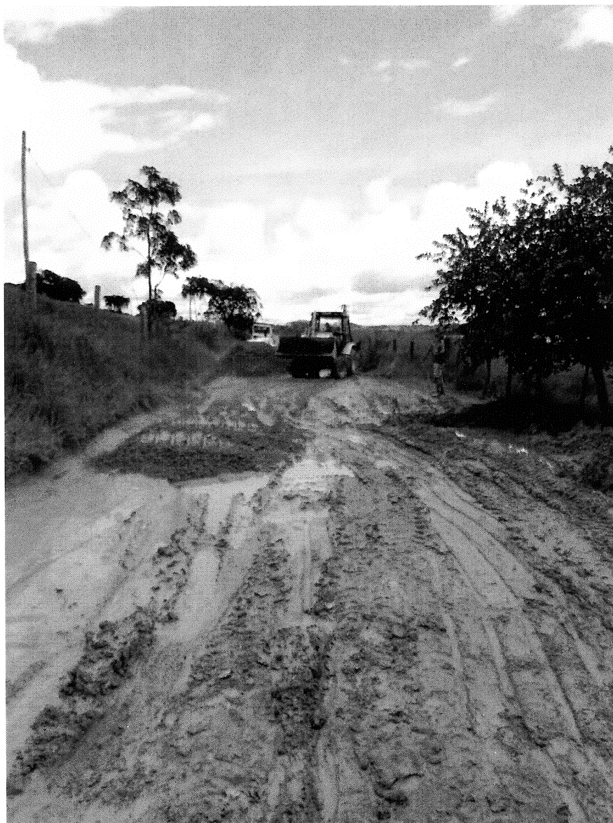
Figura 4 – Estrada de acesso a ponte do Rio Capivari
